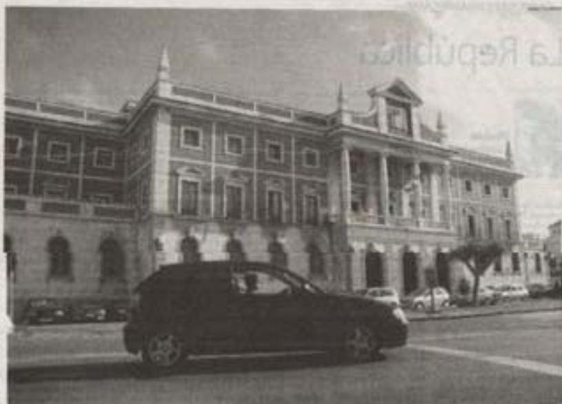
El edificio de la Aduana será demolido definitivamente como parte de la rehabilitación de la Plaza de Sevilla.
