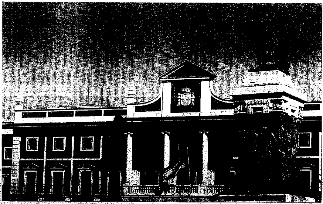
Aspecto del edificio Aduana, cuyo futuro derribo responde al proyecto de reordenación de la Plaza Sevilla.
