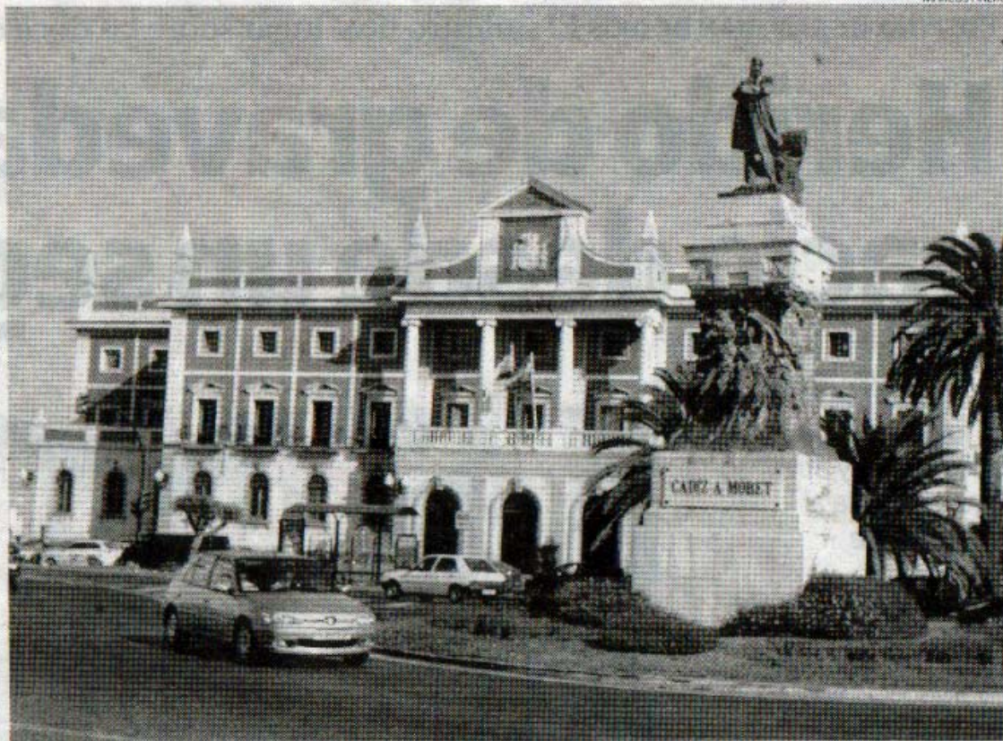
La demolición de la Aduana consigue nuevos apoyos y detractores.
