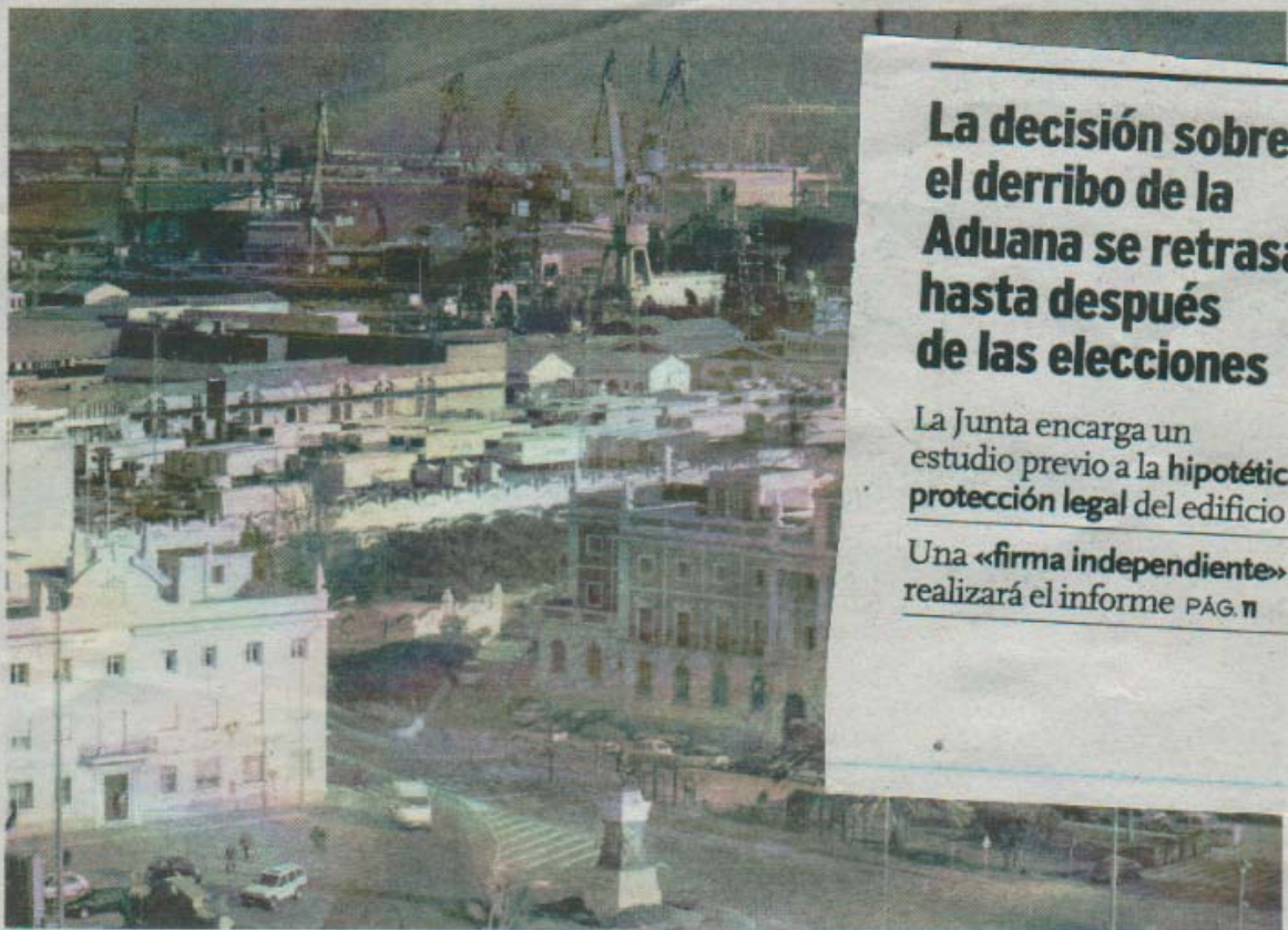
VISTA. Estado actual del edificio de Aduanas (a la derecha), en la Plaza Sevilla./L. V.
