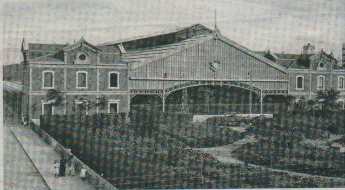
La estación de 1905 mantuvo durante una década una gran zona ajardinada en todo su frente
